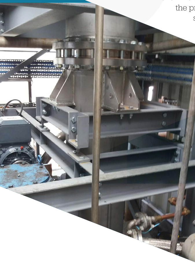
«« Steelwork 'trolley' fabrication
